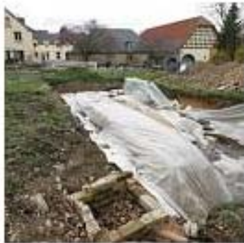
Mit Planen abgedeckt sind Fundamente der einstigen Klosteranlage. Seit Dienstag hat der Umbau des Klostergeländes Heisterbach begonnen. (Bild: Klodt)
