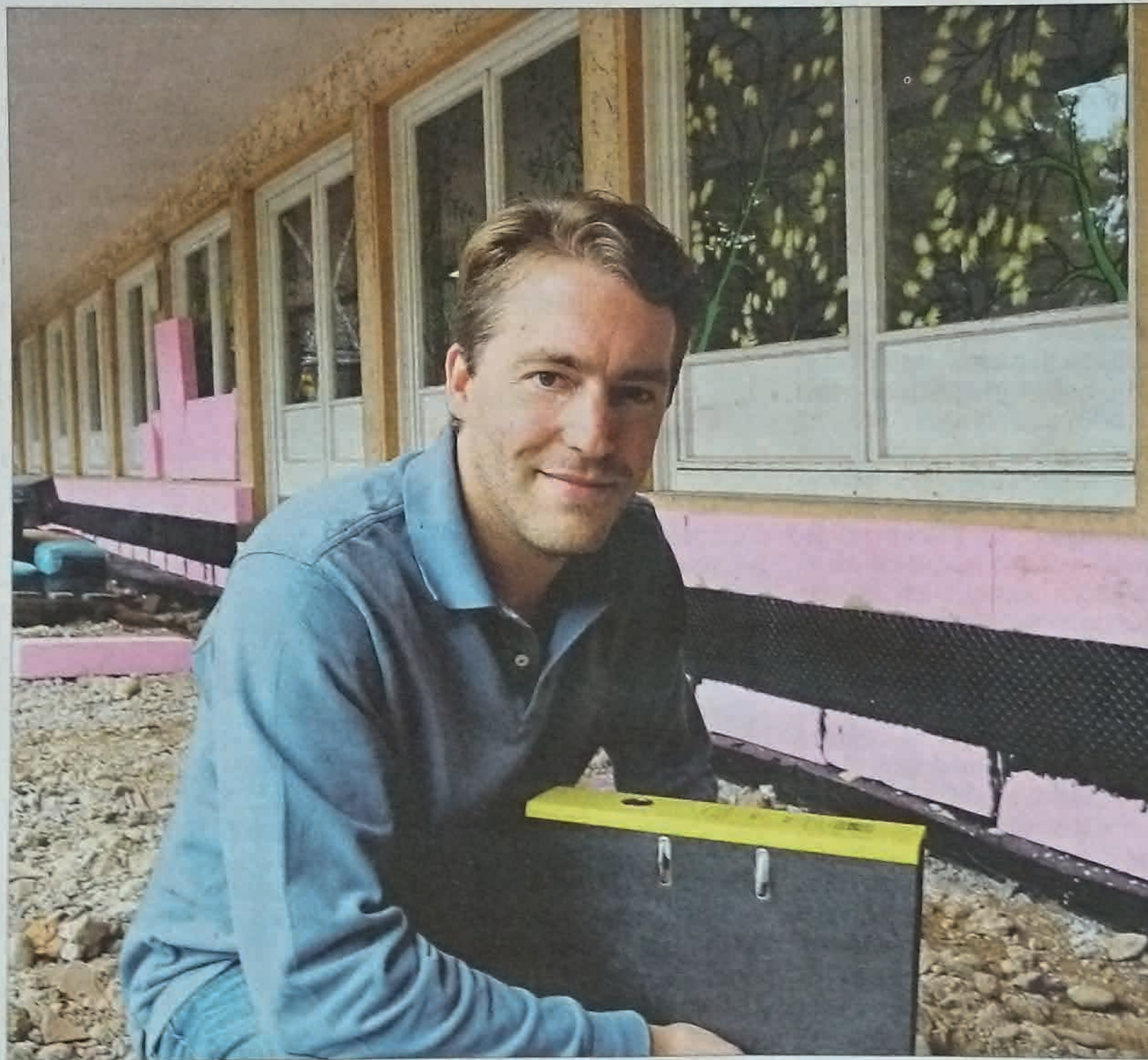
Die Arbeiten an dem Schulgebäude koordiniert Roland Pilot, Geschäftsführer der ausführenden Firma Pilot, die in Rodenkirchen ansässig ist. (Foto: Wächter)
